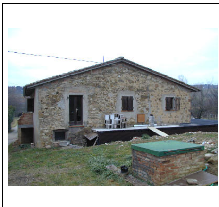
annesso con lavori in corso
