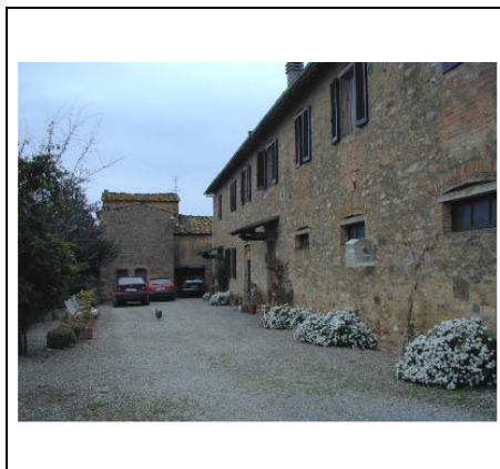
edificio principale lato sud
