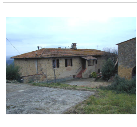
edificio principale lato nord
