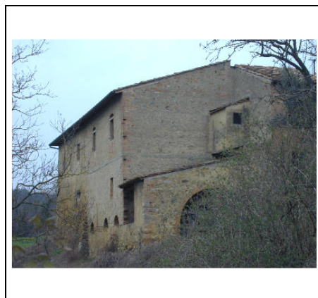
edificio principale parte sud
