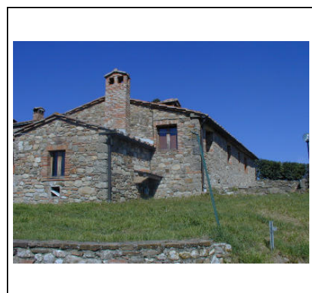
corpo a L dell'edificio nord
