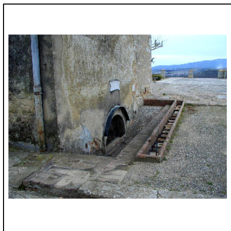
particolare edificio A
