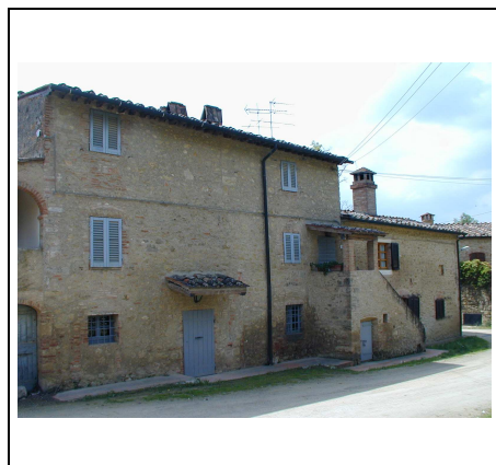
lato su strada parte ovest
