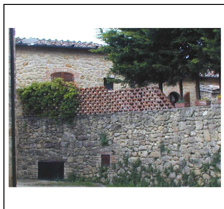
muro di recinzione
