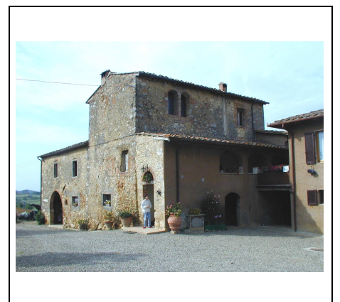
parte non ristrutturata
