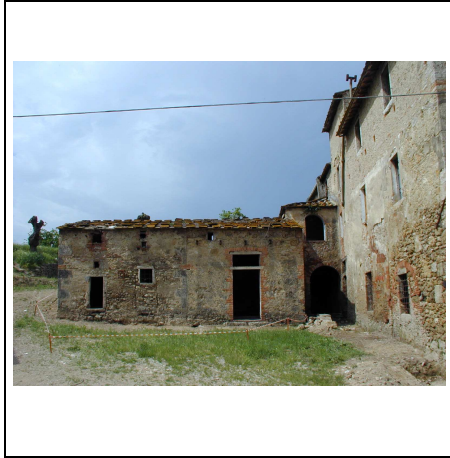
edificio principale parte sud
