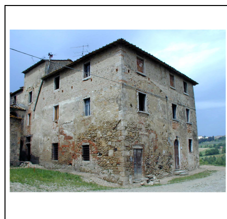
edificio principale parte sud
