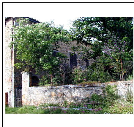
facciata sul giardino
