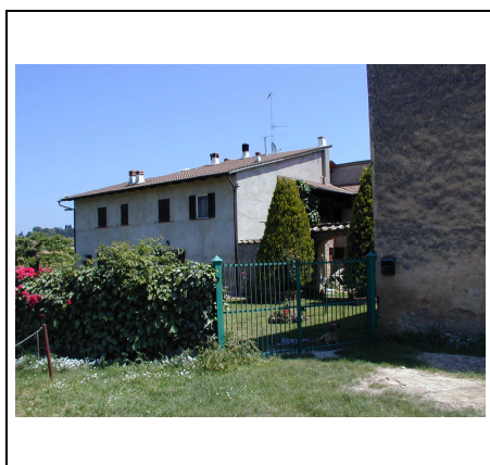
edificio principale lato ovest
