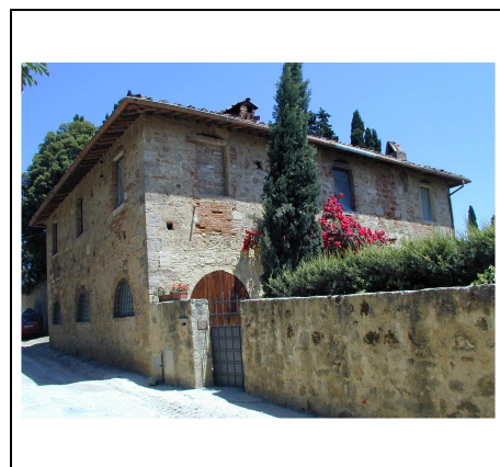
edificio principale lato sud
