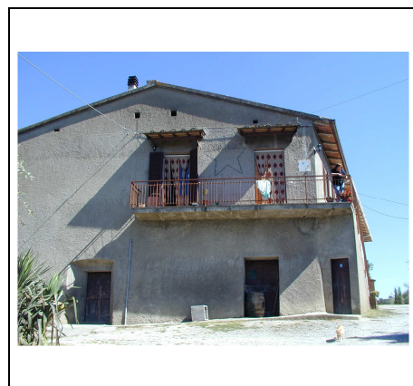
edificio principale lato nord
