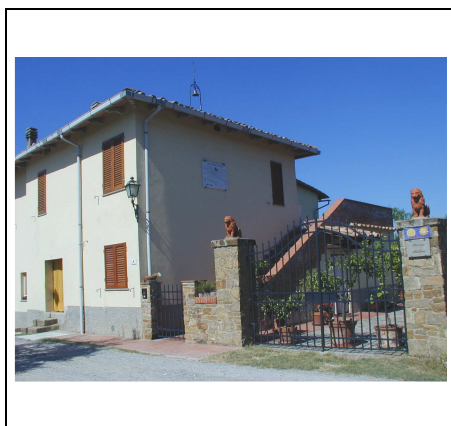
ed. principale lato sud-ovest.
