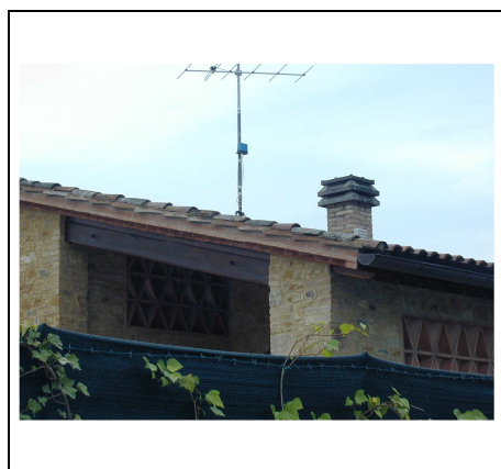
dettaglio del tetto
