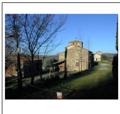
veduta generale edifici A,B,E
