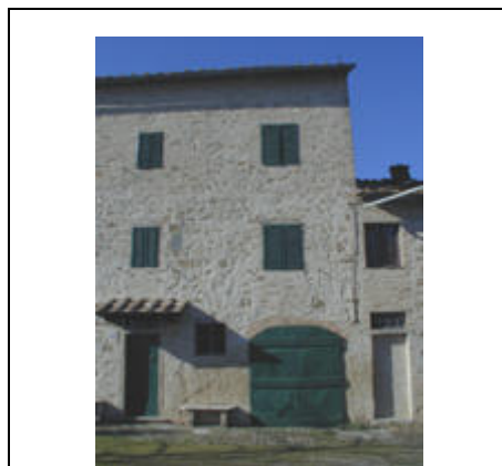
edificio principale lato sud
