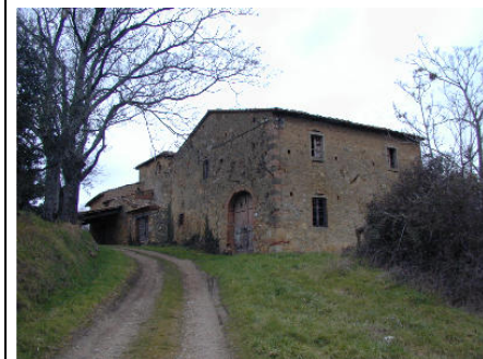
veduta dalla strada di accesso
