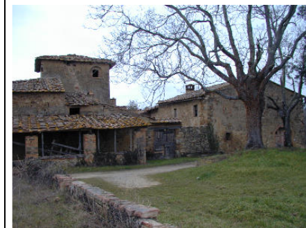
veduta con la corte chiusa
