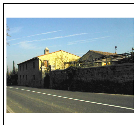
l'edificio dalla strada
