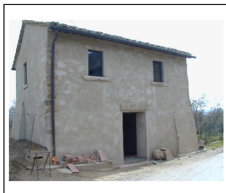
annesso in ristrutturazione
