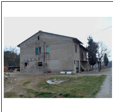
corpo aggiunto sul retro
