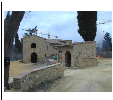
edificio principale lato sud
