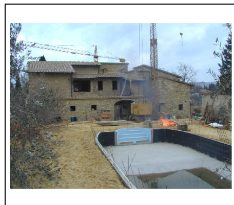
edificio principale lato nord
