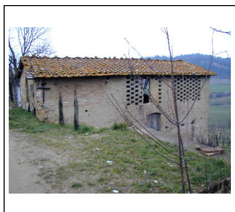
annesso non ristrutturato
