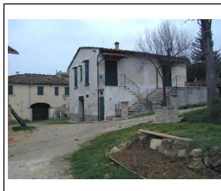
parte est aggiunta
