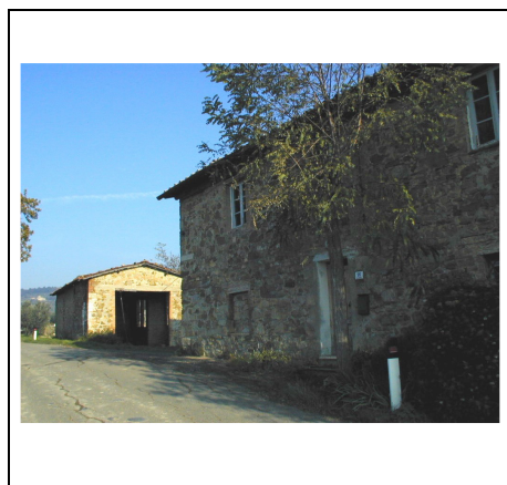
lato su strada
