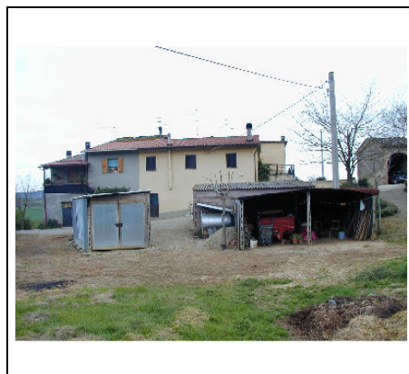
edificio principale da ovest
