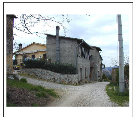
edificio principale da sud-est
