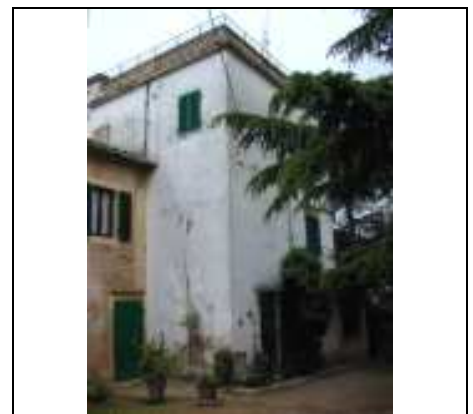
edificio principale (ed. C)
