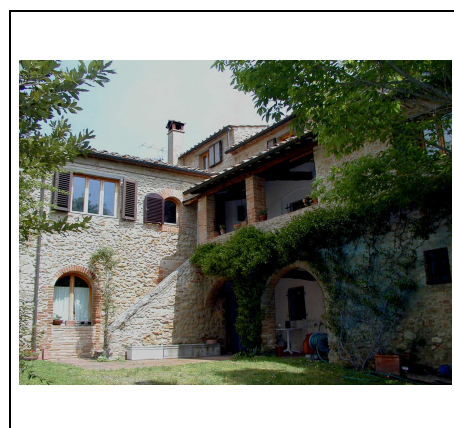
edificio principale lato sud
