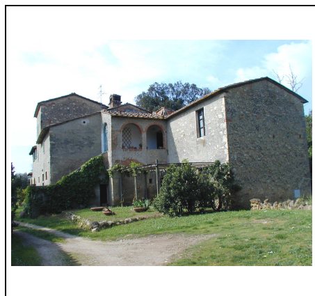
edificio principale lato est
