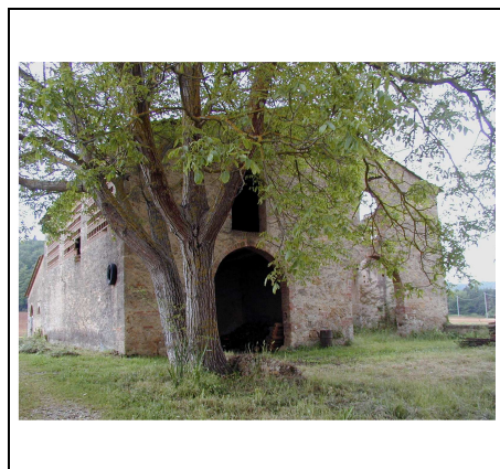
annesso di pregio semi crollato
