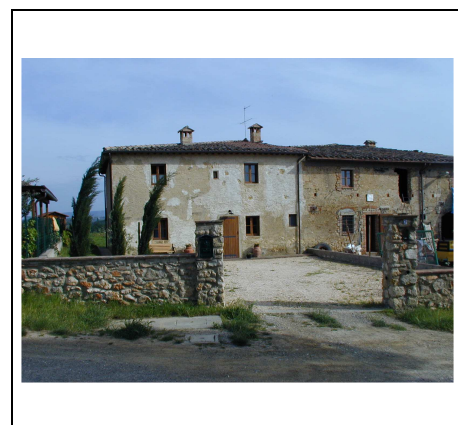
edificio principale lato nord
