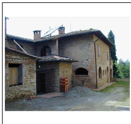
edificio principale lato est
