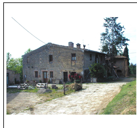
edificio principale lato sud
