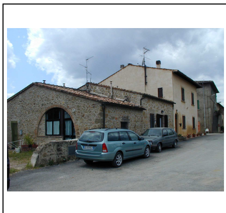
edifici secondari in aderenza
