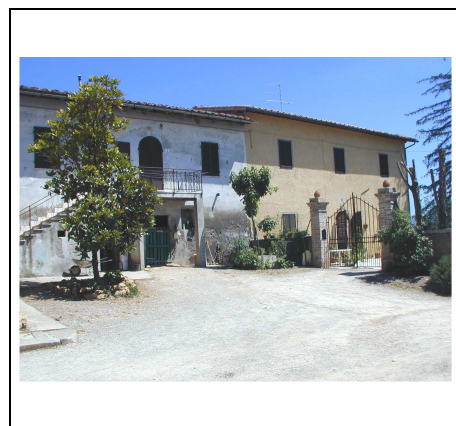
edificio principale lato sud
