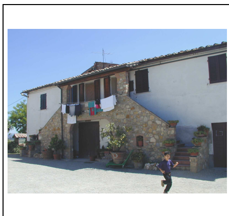
edificio principale lato nord
