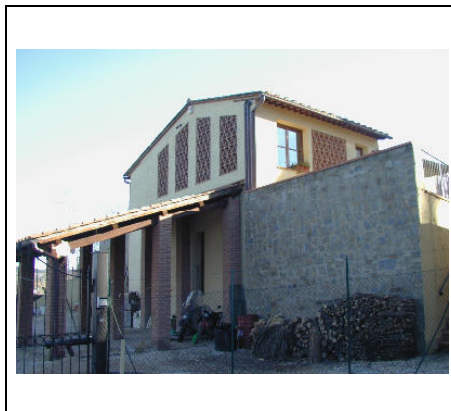
lato con tettoia
