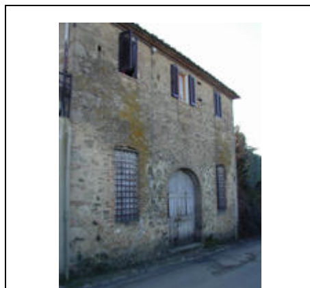
particolare lato su strada
