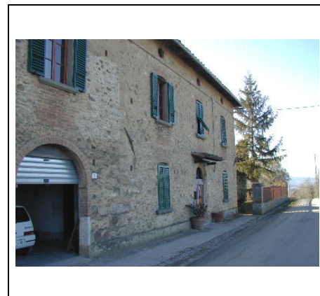
lato su strada
